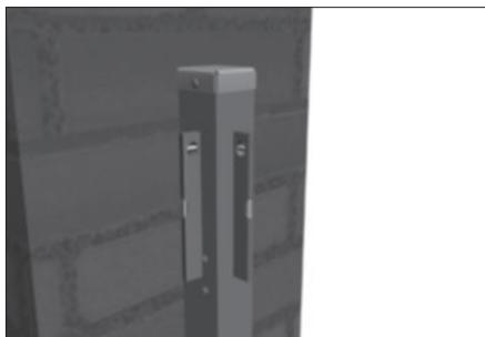
Строительным уровнем проверьте вертикальность расположения двух перпендикулярных плоскостей каждого столба. Выставьте столбы относительно друг друга в одной плоскости с помощью уровней.
