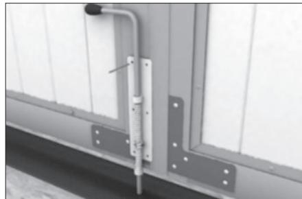
Разметьте отверстия для установки задвижки на одной из створок.
