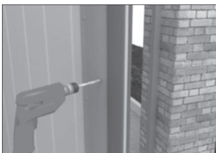
Просверлите 2 отверстия  $\varnothing 12$  в створке.
