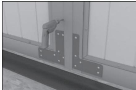
Просверлите 6 отверстий  $\varnothing 4$  мм.
