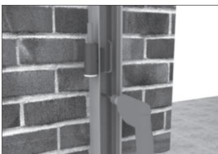
Просверлите алюминиевый профиль «корпус столба» по всей высоте с шагом не более 500 мм сверлом 4 мм.
